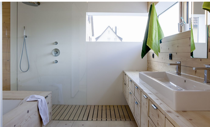
Durch und durch wurde mit Holz geplant. Wo es geht, bleibt es sichtbar. So auch im Bad. Nur die Flächen, die ausgiebig mit Wasser beaufschlagt werden, sind wasserfest ausgeführt.
