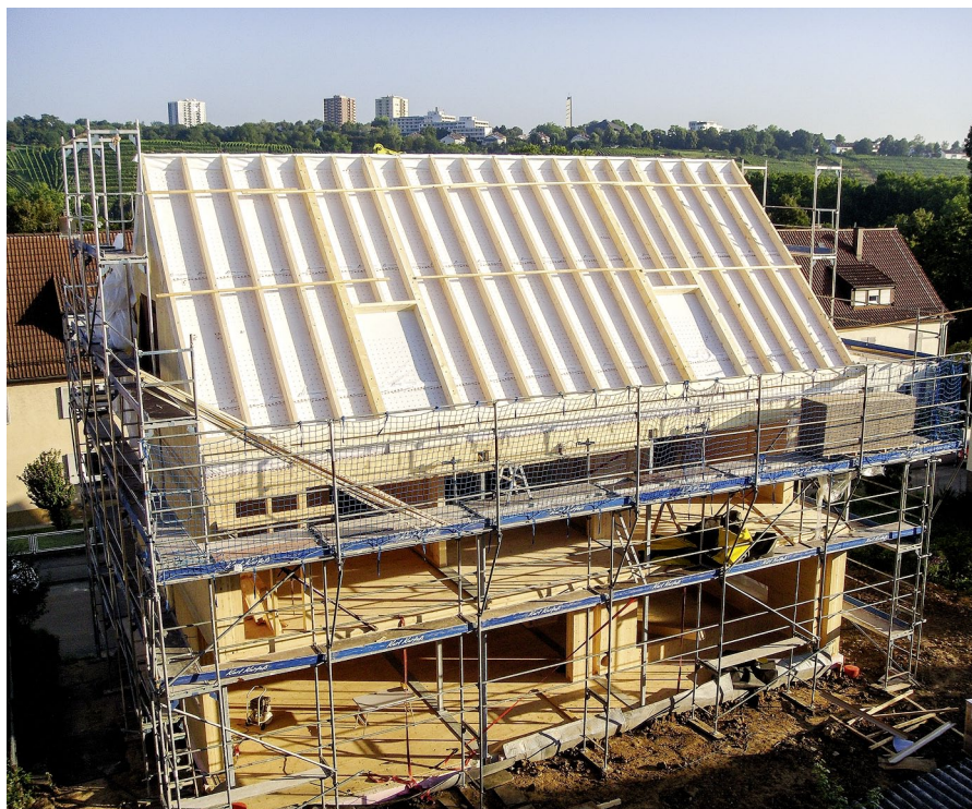
Das Tragwerk besteht aus Brettsperrelementen. Sie entstammen dem System Nur-Holz des Schwarzwälder Holzbauunternehmens Rombach.
