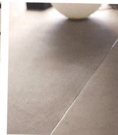
Individuell auch der Boden: Gefertigt aus einem pastösen Spachtel, anschließend geschliffen und versiegelt. Die Dehnfuge läuft zwischen den Deckenstützen.
