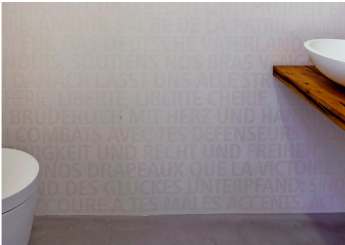
Der Wasserzeicheneffekt entsteht durch Glanz auf dem matten Putz
