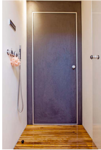
Eine hydrophobierende, aber dennoch atmungsaktive Lasur ersetzt die Fliesen in der Dusche
