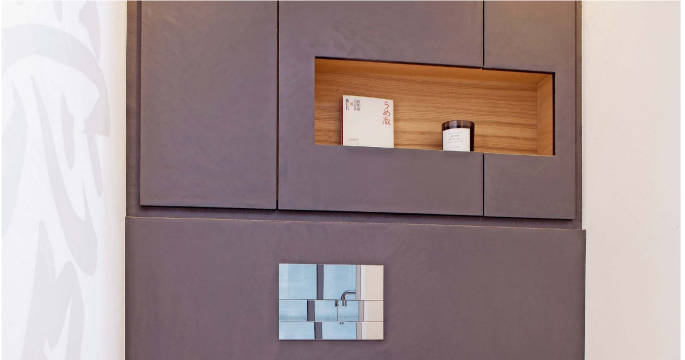
Durchgefärbter Kalkpressputz auf Wänden und Möbeln sowie Wasserzeichen in der Wand verleihen dem WC etwas Einzigartiges
