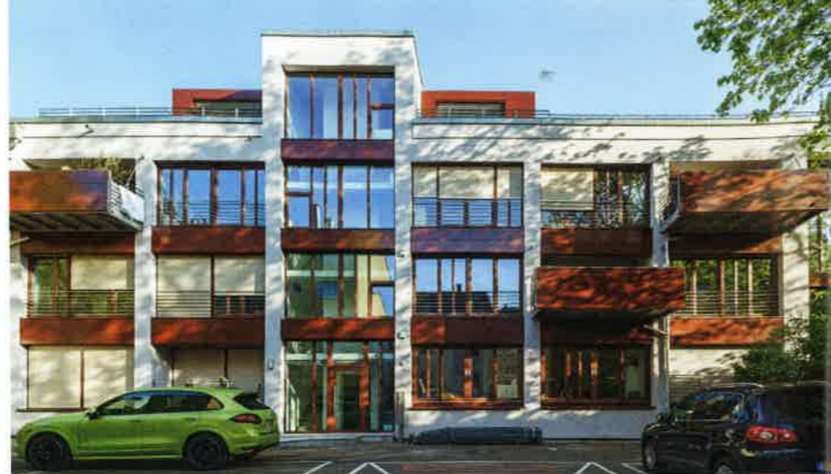
Von außen ist heute nicht mehr zu erkennen, dass es sich um eine ehemalige Gewerbeimmobilie handelt.
